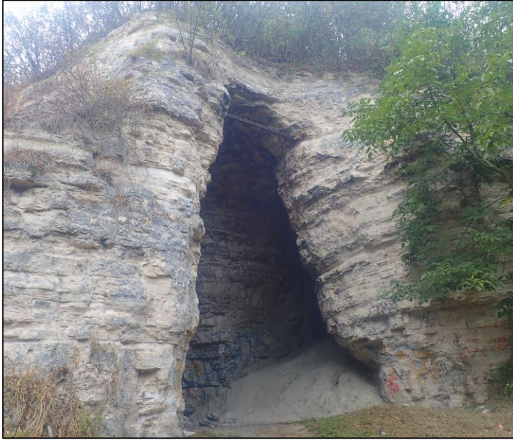
Entrée en cavage des carrières de Gagny
